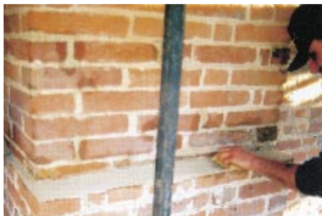
■ A sinistra, un intervento di ristilatura dei giunti in malta.
